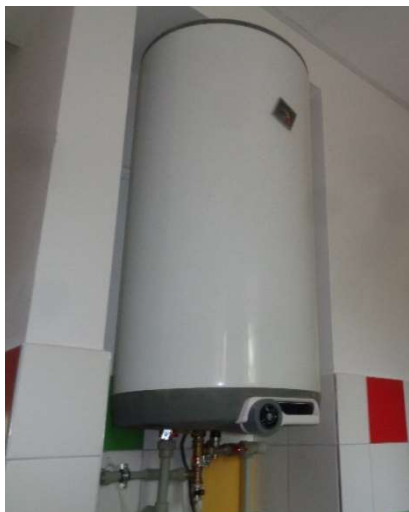
Obrázek č. 2.1.3.1: Elektrický zásobníkový ohřívač vody Dražice OKCE 125
