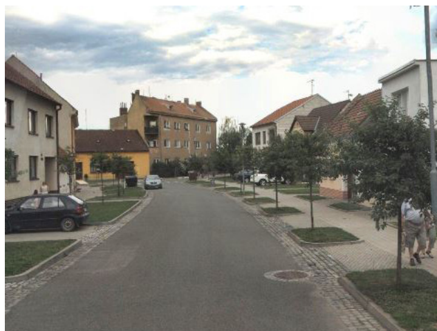
1 Řešení rozšíření vozovky dlážděným pásem
