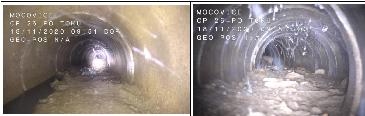
Obr. 12 Kanalizační úsek Š4-5 – Š4-4
