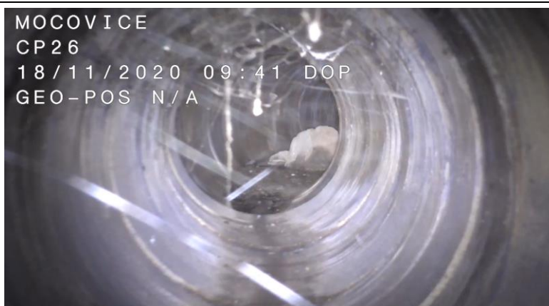
Obr. 11 Kanalizační úsek Š4-5 – Š4-8
