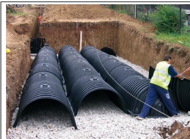
Obr. 35 Vsakovací tunel (zdroj: voda.tzb-info.cz)
