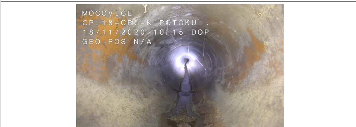
Obr. 13 Kanalizační úsek Š4-3 – Š4-2
