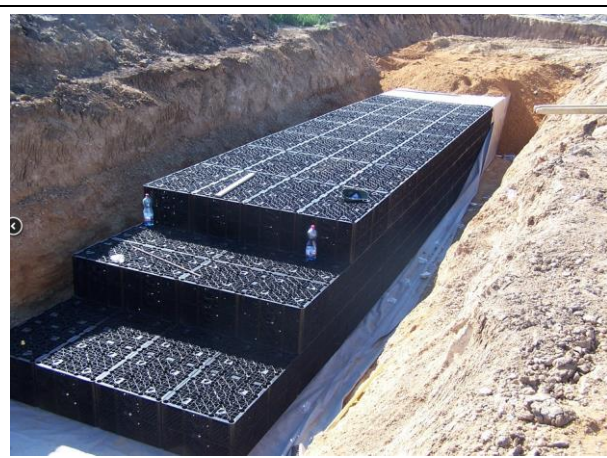
Obr. 36 Vsakovací bloky (zdroj: voda.tzb-info.cz)
