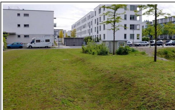
Obr. 33 Vsakovací průleh (zdroj: mmr.cz)
